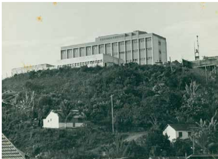
Edificação do Hospital Evangélico de Vila Velha
