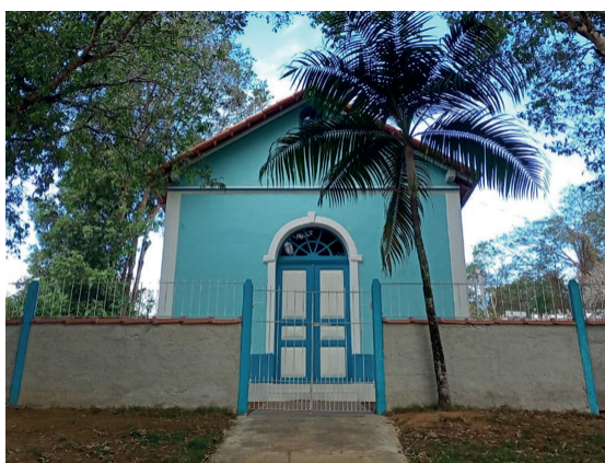
Córrego da Ponte
